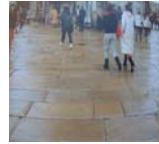
-Paviment de lloses de granit que rellisquen quan es mullen
