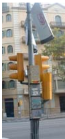
-Pal de fanal multius, soste tres semafors que es solapen, caixes d'instal.lacions, i cartells publicitaris. -Av / Diagonal.
